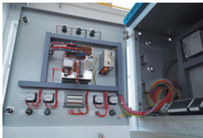
Замена релейного шкафа модернизируемой ячейки осуществляется путем демонтажа имеющегося и установки нового релейного шкафа.
